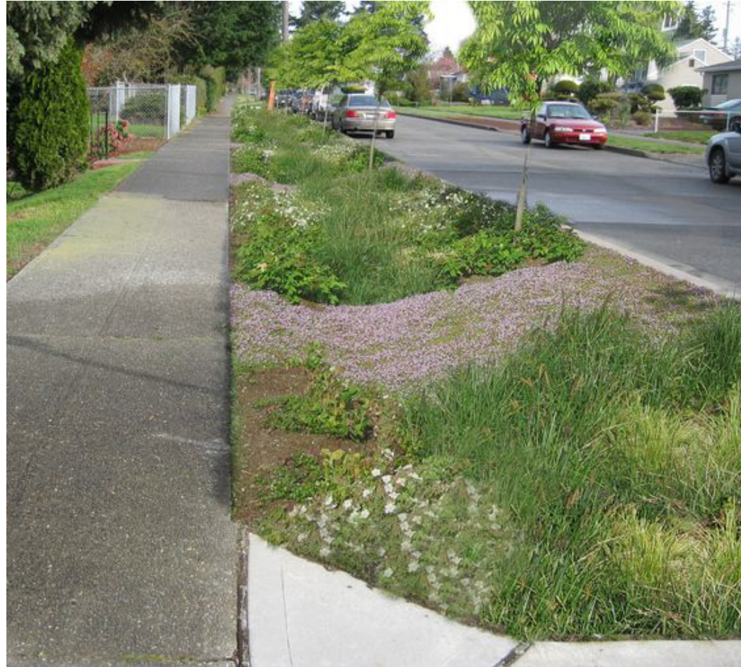
opvang hemelwater in de berm
